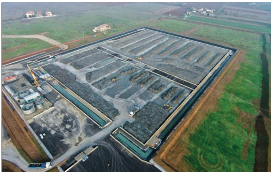
Fig. 11 - Predisposizione dei cumuli presso il deposito intermedio di C.na Romanellotta (fonte Cociv)
